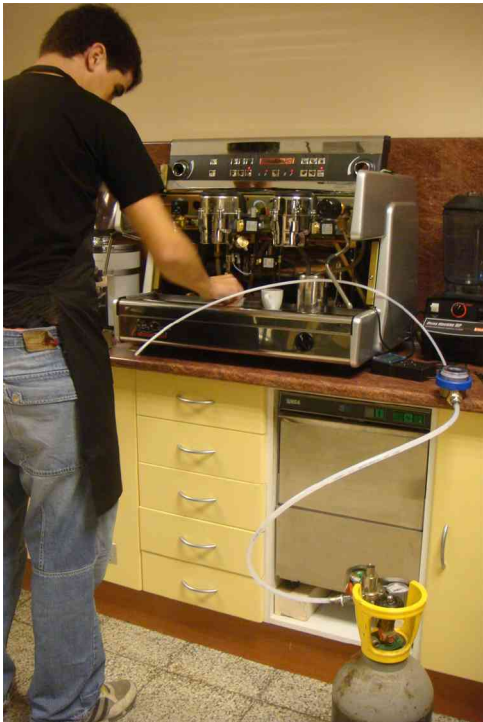
Moments de la instal·lació de la conducció del CO 2 cap al grup de la màquina.
